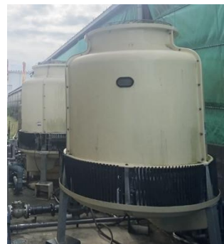
北島工場の水冷式クーリングタワー
