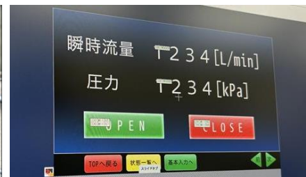
エアーバルブ 遠隔開閉画面
